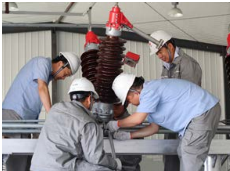
龙源黑龙江公司曙光实训基地 开展输变电设备实操培训
